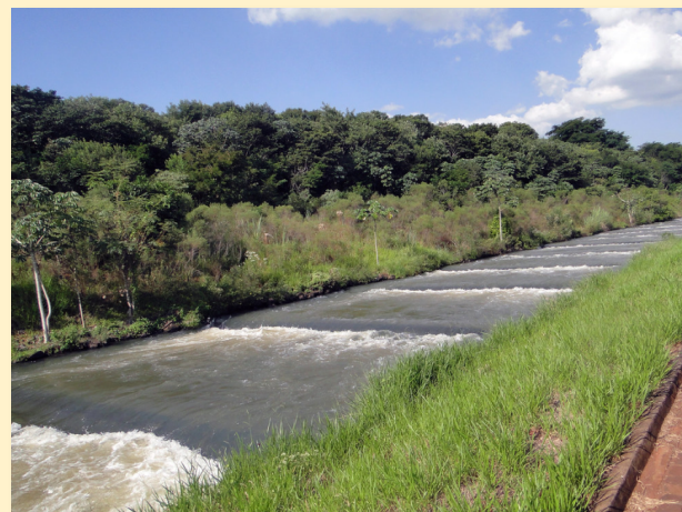
Figura 48 - Canal natural para transposição de peixes.
