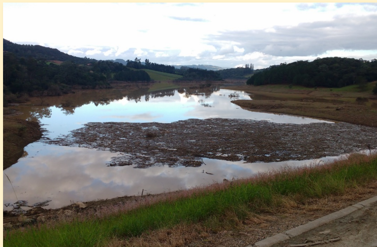
Figura 47 - Acúmulo de resíduos vegetais em reservatório de barragem de contenção de cheias.
